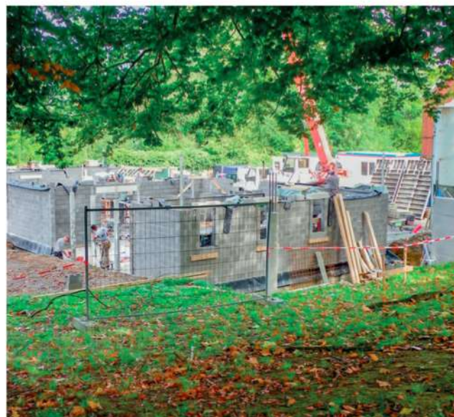
Début des travaux de construction de la crèche.
